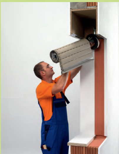
Alten Rollladen aus dem Kasten entfernen!
